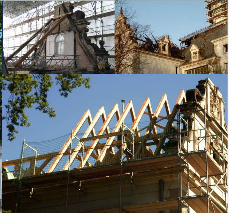
Schloss SÜDFLÜGEL - Dachwiederaufbau
