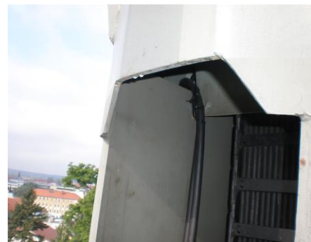
Vorhandene Öffnung unterhalb des Gelenks vor der Instandsetzung
