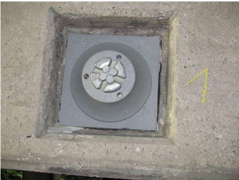
Freigelegter Spannankerkopf
