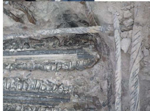
Freigelegter Spannstahl
